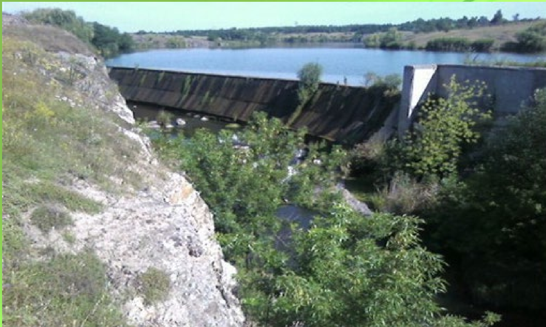
Водозабірна споруда на річці Сутоклей
